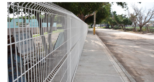
Rehabilitación de la Unidad Deportiva primera etapa.
