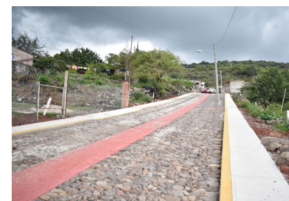
Empedrado tradicional en la calle Durazno en la localidad de Mis-maloya.
