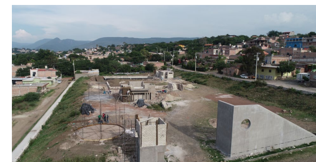
Construcción de Centro Polideportivo Los Nogales.
