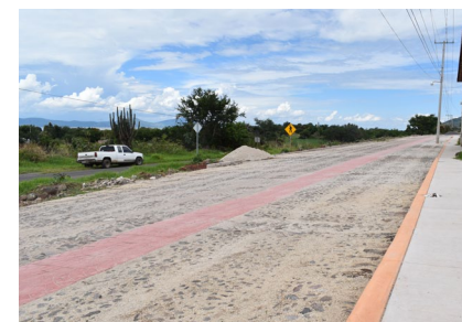
Empedrado tradicional en el Camino al Centro de Salud, en la cabecera municipal.
