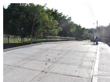
Puente calle Iturbide en el Ejido.
