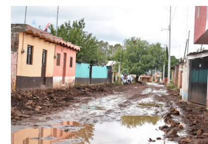
Pavimento de concreto en la calle Francisco Villa en la localidad de el Volantín.
