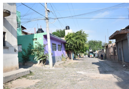
Pavimento de concreto en la calle Tabasco.
