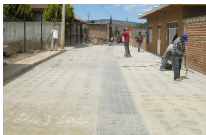
Pavimento de concreto hidráulico en la calle Melchor Ocampo 2da etapa en el Volantín.
