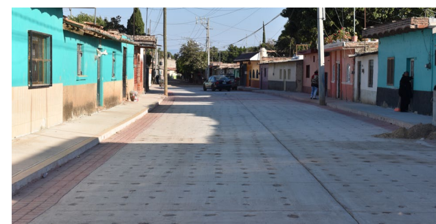
Pavimento de concreto en la calle Emiliano Zapata 2da etapa (Jardín de Niños)
