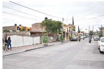
Rehabilitación de imagen urbana en la calle Madero segunda etapa.
