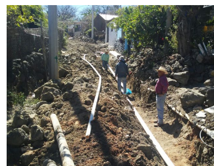
Obras de agua potable y alcantarillado.
