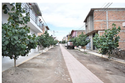
Pavimento de empedrado en la calle Vicente Suárez en la cabecera municipal.
