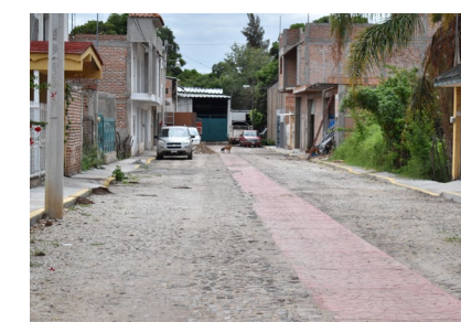
Empedrado tradicional de la calle Aguacate en la cabecera municipal.
