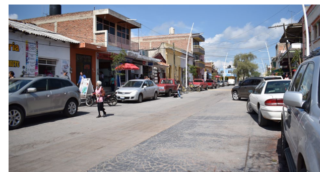
Rehabilitación de imagen urbana en la calle Madero primera etapa.
