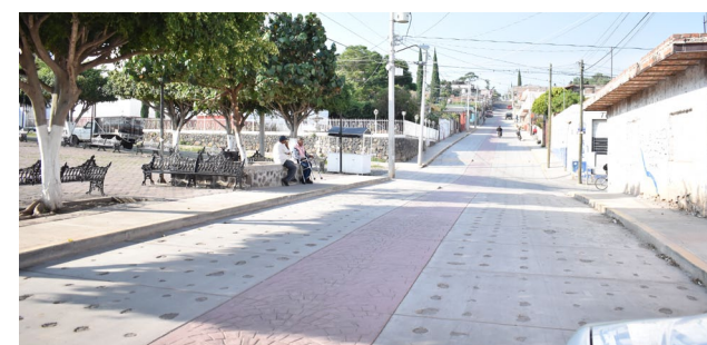
Construcción de pavimento en concreto en la calle México 2da etapa.
