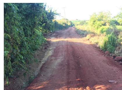
Programa mantenimiento de brechas (balastreo)
